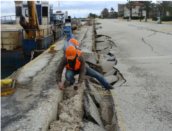
Σημείο H13, κοντά στο ελεύθερο μέτωπο η οριζόντια μετακίνηση έφτασε το 1 μέτρο.
