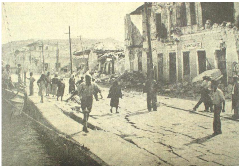
Σχήμα 4-11 Βλάβες στον κρηπιδότοιχο μετά το σεισμικό γεγονός του 1953
