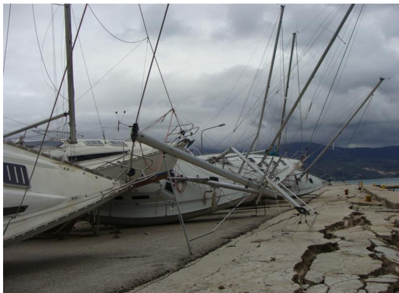
Σχήμα 3-18 Οι καταστροφικές συνέπειες του 2ου σεισμού στο Λιμάνι του Ληξουρίου. Ανατροπή των σκαφών που εδράζονταν στον βόρειο υπήνεμο μώλο.
