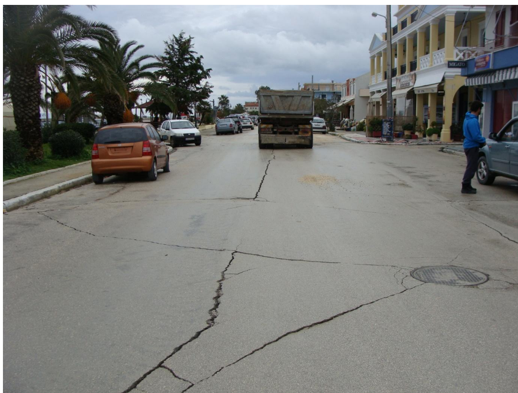
Άνοιγμα ρωγμών παράλληλα με το παραλιακό μέτωπο (τομή 18, σημείο B18)
