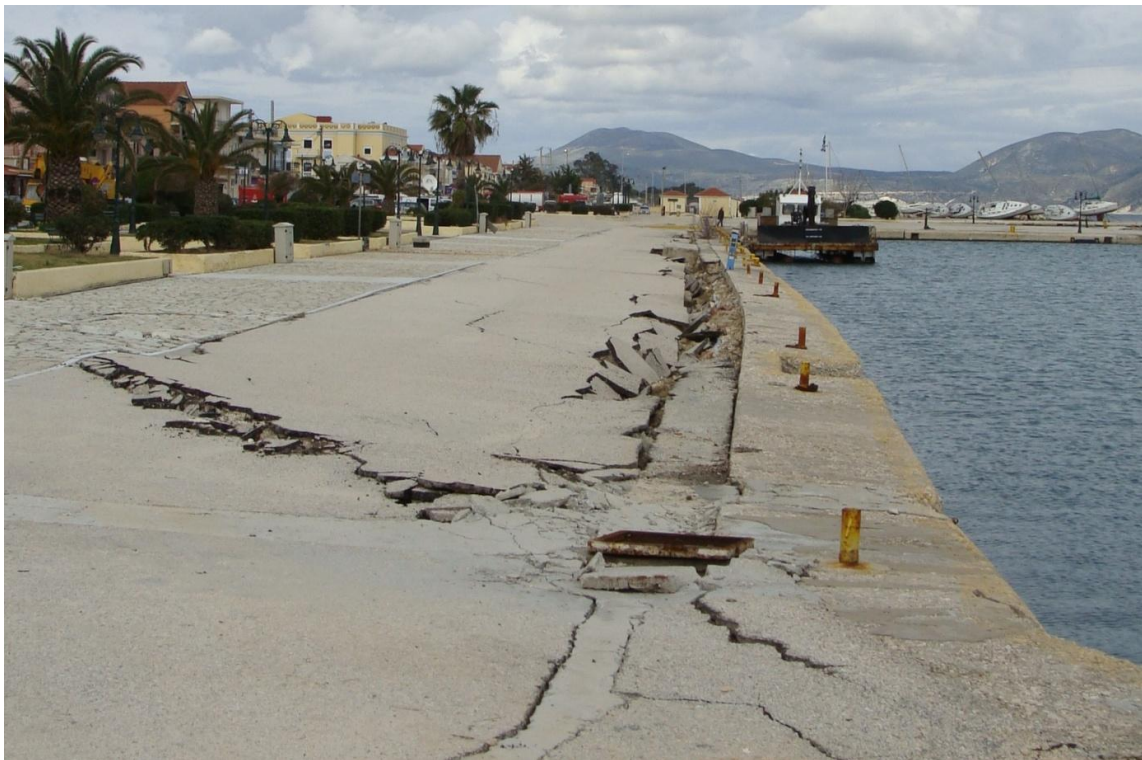
Σχήμα 5-3 Βλάβες κατά μήκος του Δυτικού κρητιδώματος του Λιμένα Ληξουρίου, λόγω πλευρικής εξάπλωσης.
