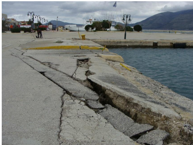
Σχήμα 3-13 Οι κρηπιδότοιχοι του Λιμανιού του Ληξουρίου κατεστραμμένοι από την σφοδρότητα του σεισμού
