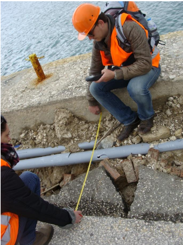
Σημείο J10 . Εκτεταμένες ζημιές στον κρηπιδότοιχο του λιμένα με την οριζόντια μετακίνηση να φτάνει κοντά στο ελεύθερο μέτωπο τα 110cm.
