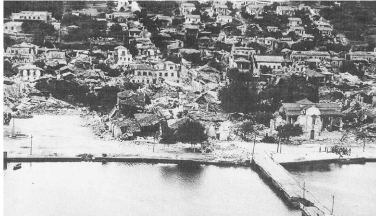
Σχήμα 4-10 Το λιμάνι του Αργοστολίου μετά τον καταστροφικό σεισμό του 1953
